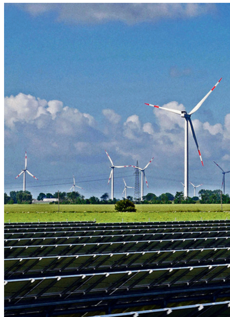
▲ Noch ist unklar, ob Windenergie, Solarenergie oder Wasserkraft die dominante Energiequelle der Zukunft sein wird.
