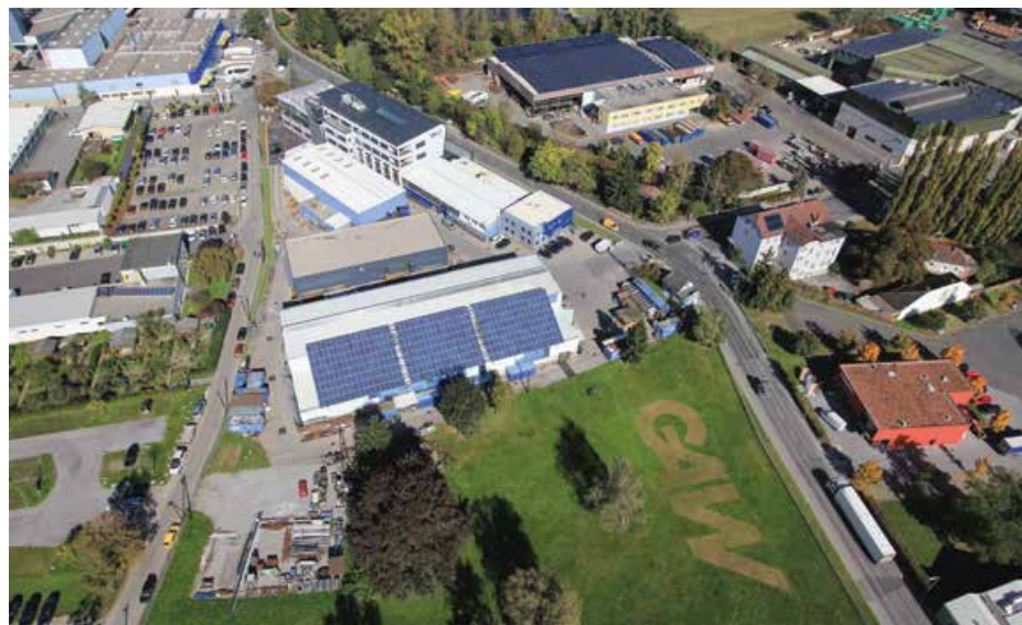
▲ Auf 750 m 2 Hallendachfläche produziert die GAW in Graz Strom mit Photovoltaik-Paneelelen.
